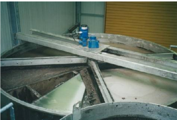
Flottateur PUROSTAR Ø3m Application : abattoir de volailles Débit = 15m 3 /h Rendement = 95%
