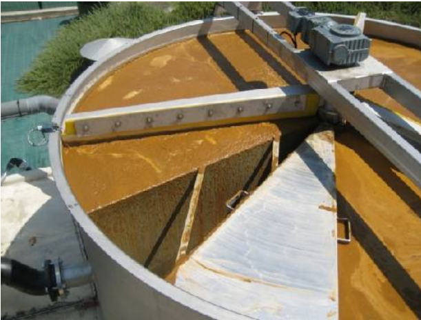
Flottateur PUROSTAR Ø3m Application : Huiles essentielles Débit = 15m 3 /h Rendement = 95%
